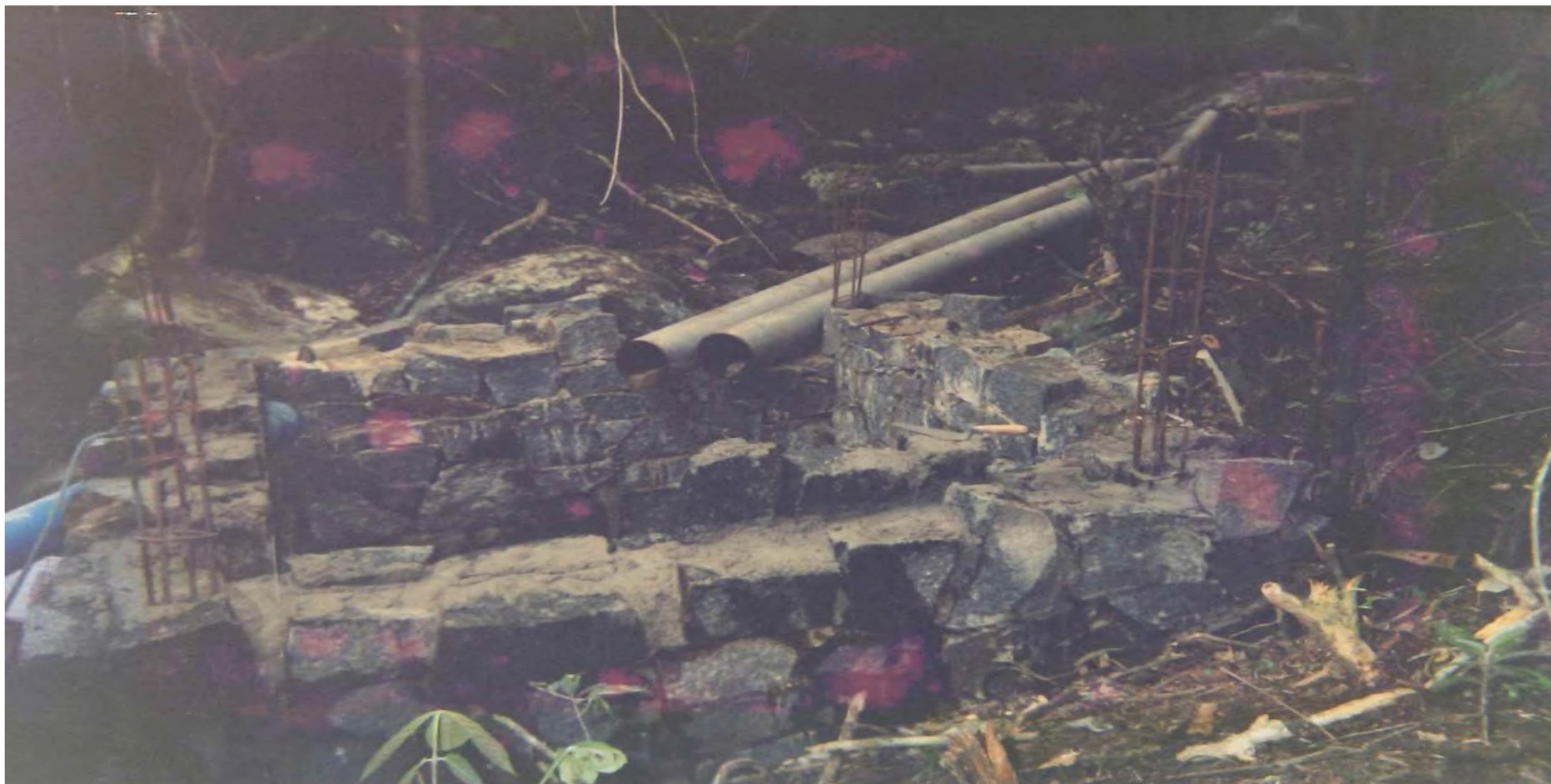
Construção da câmara fria na Praia Mansa. 1997
