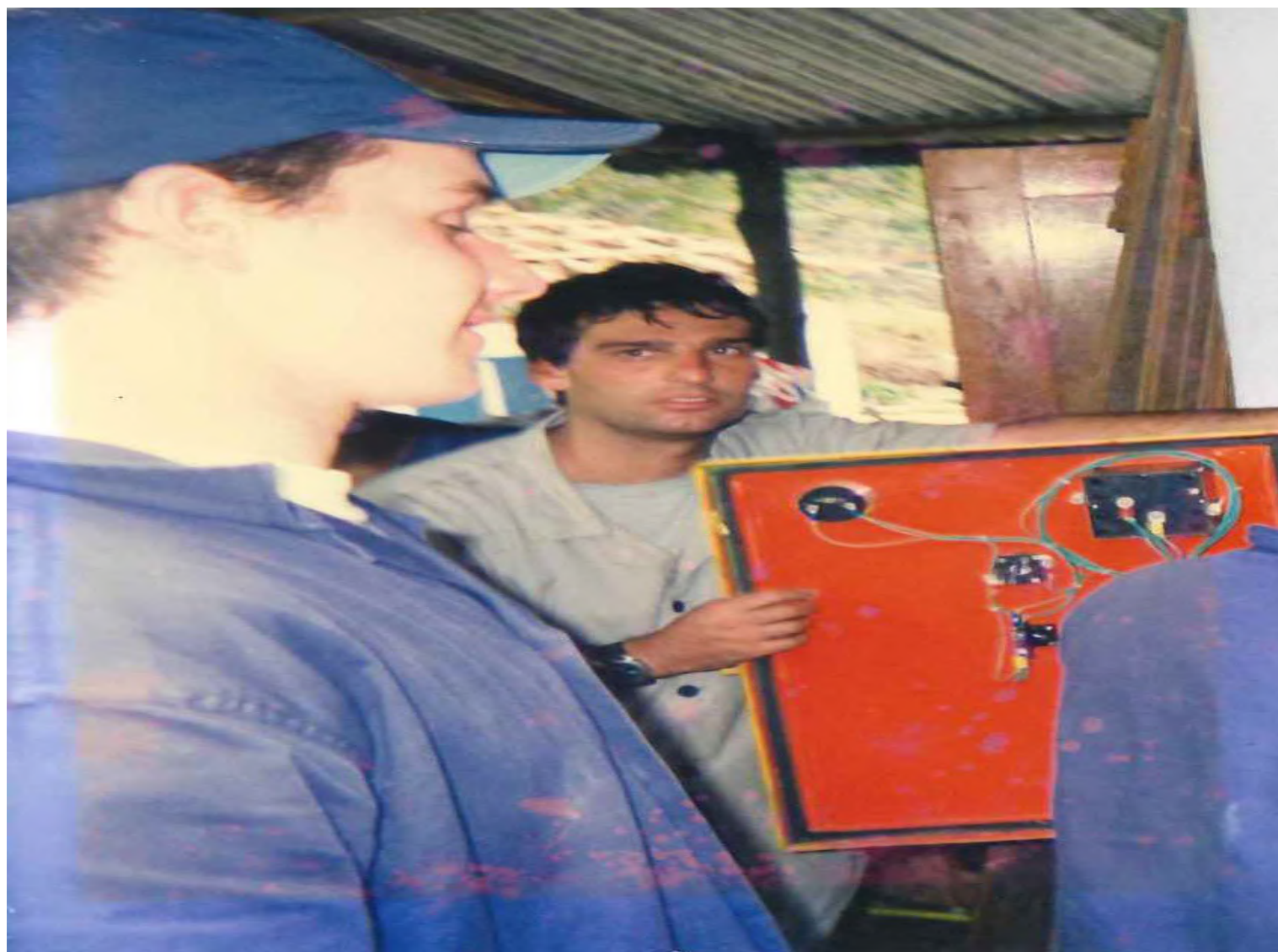
Painel de controle câmara fria. 1997
