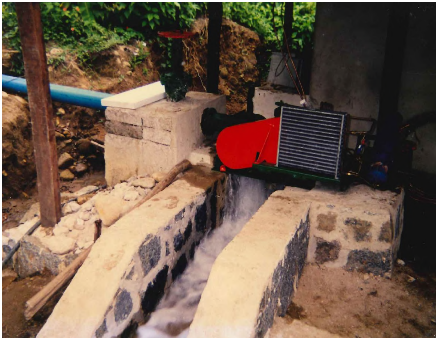
Construção da câmara fria.1997
