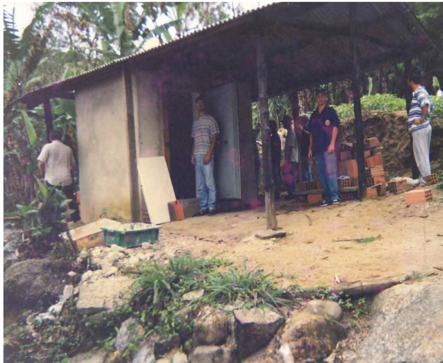
Construção da câmara fria na Praia Mansa. 1997
