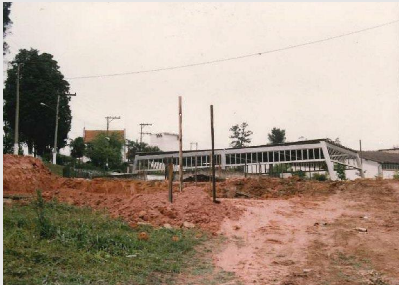
Obras na Estrada dos Alvarengas. Déc. 1990
