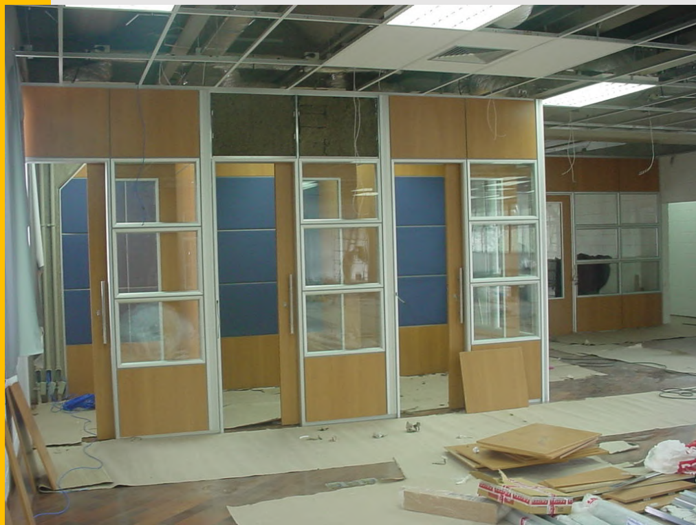
Construção da Biblioteca EM/FTT.2004
