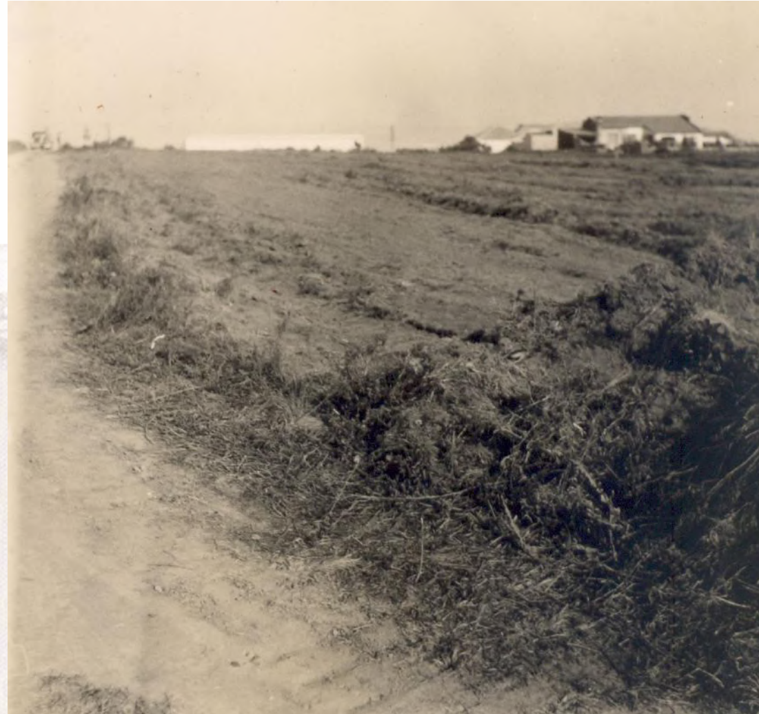
Terreno da Fábrica I, em Rudge Ramos. 1955
