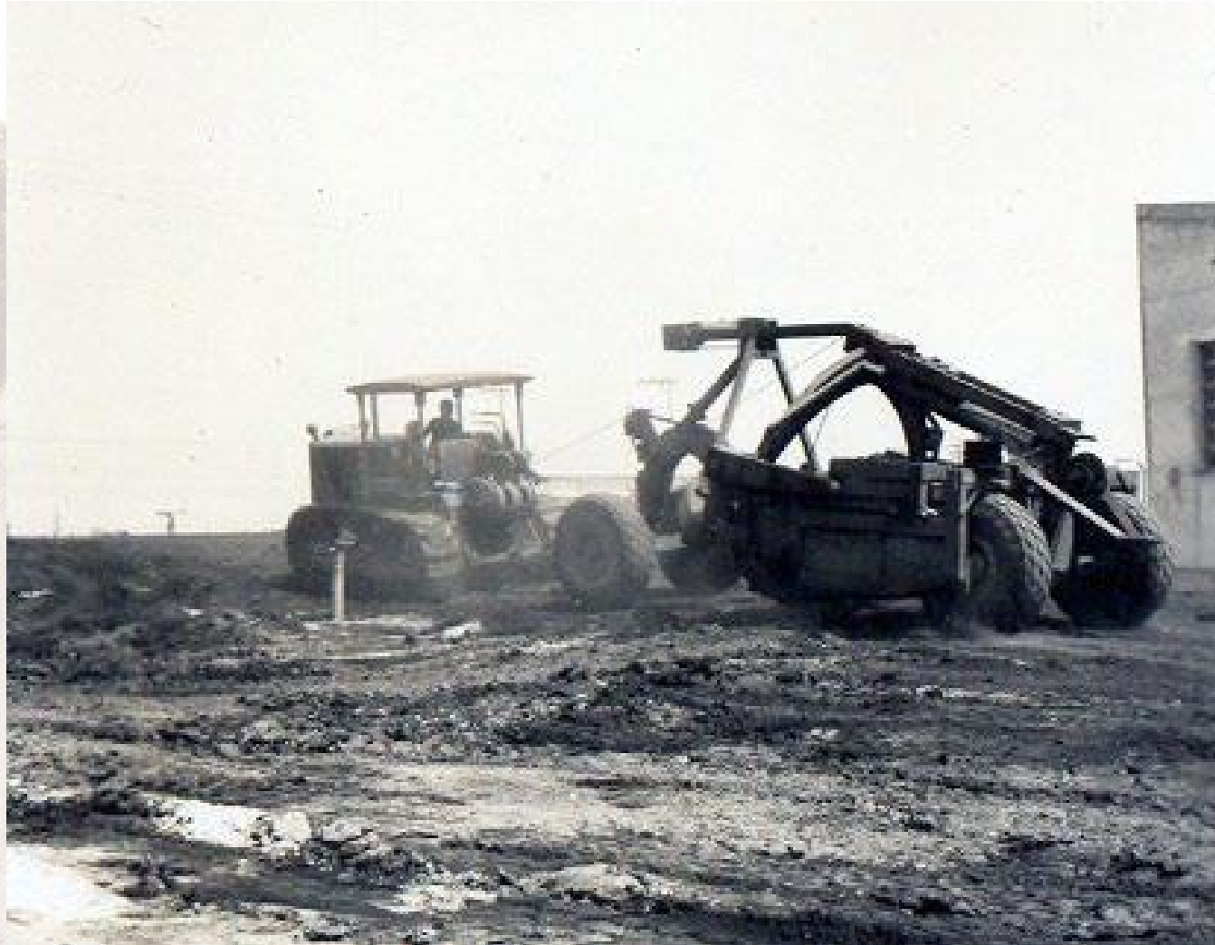
Terreno da Fábrica I, em Rudge Ramos. 1955
