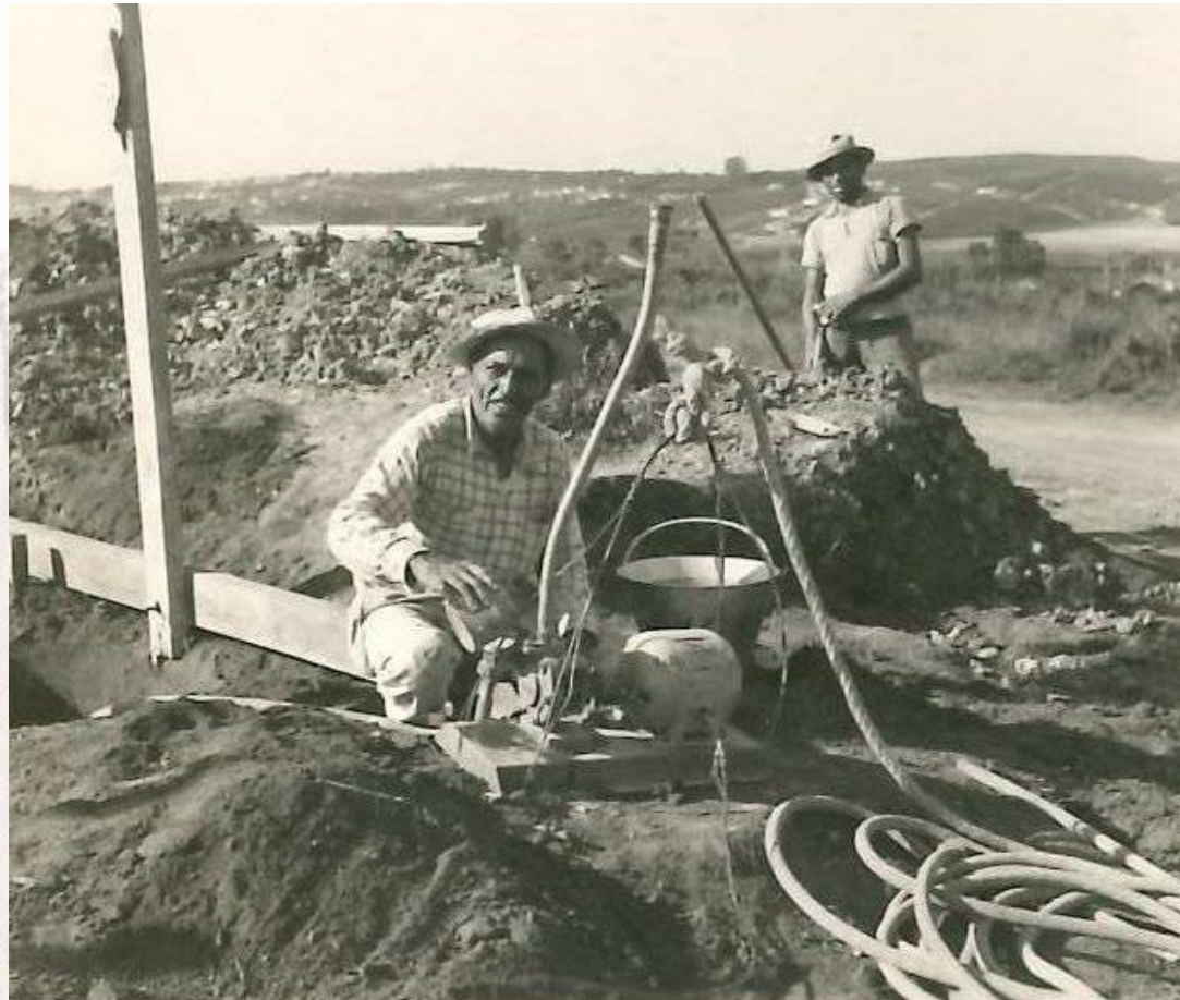
Construção da Fábrica I, em Rudge Ramos. 1955
