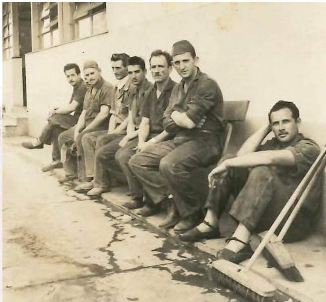
Construção da Fábrica I, em Rudge Ramos. 1955
