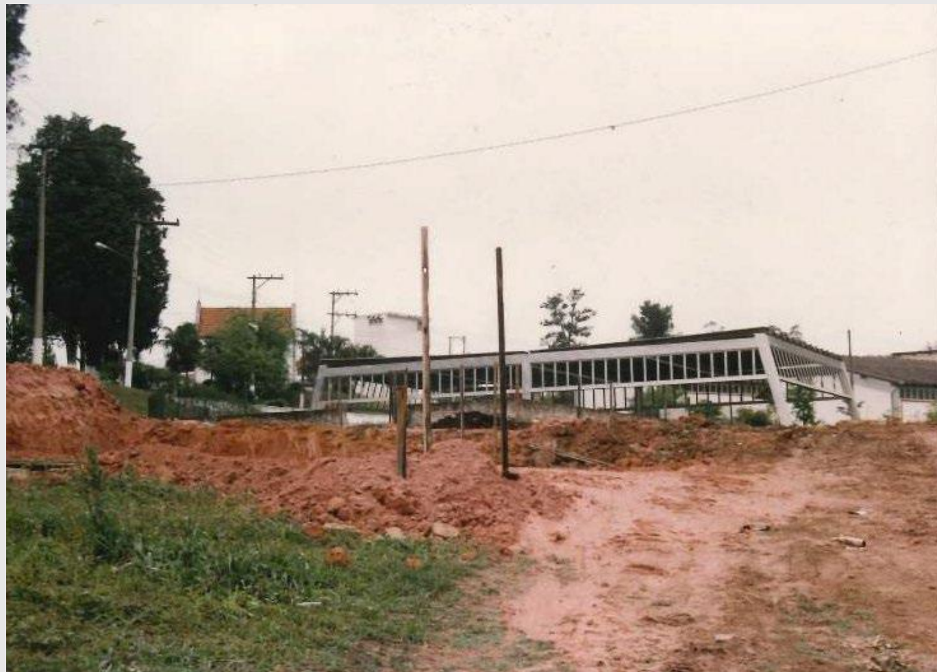
Obras na Estrada dos Alvarengas. Déc. 1990
