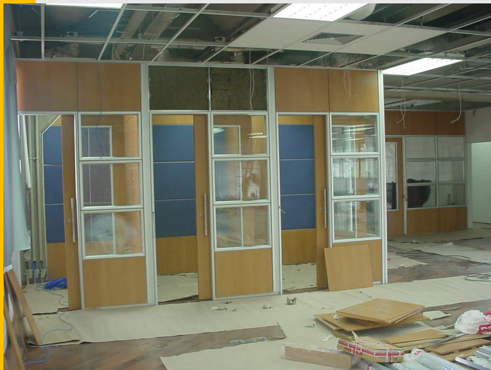
Construção da Biblioteca EM/FTT.2004
